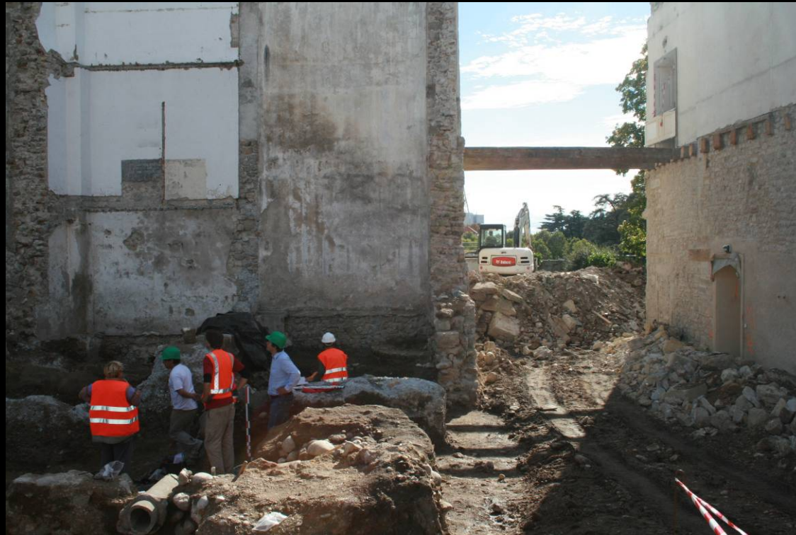
Démolition et évacuation à proximité du chantier archéologique
